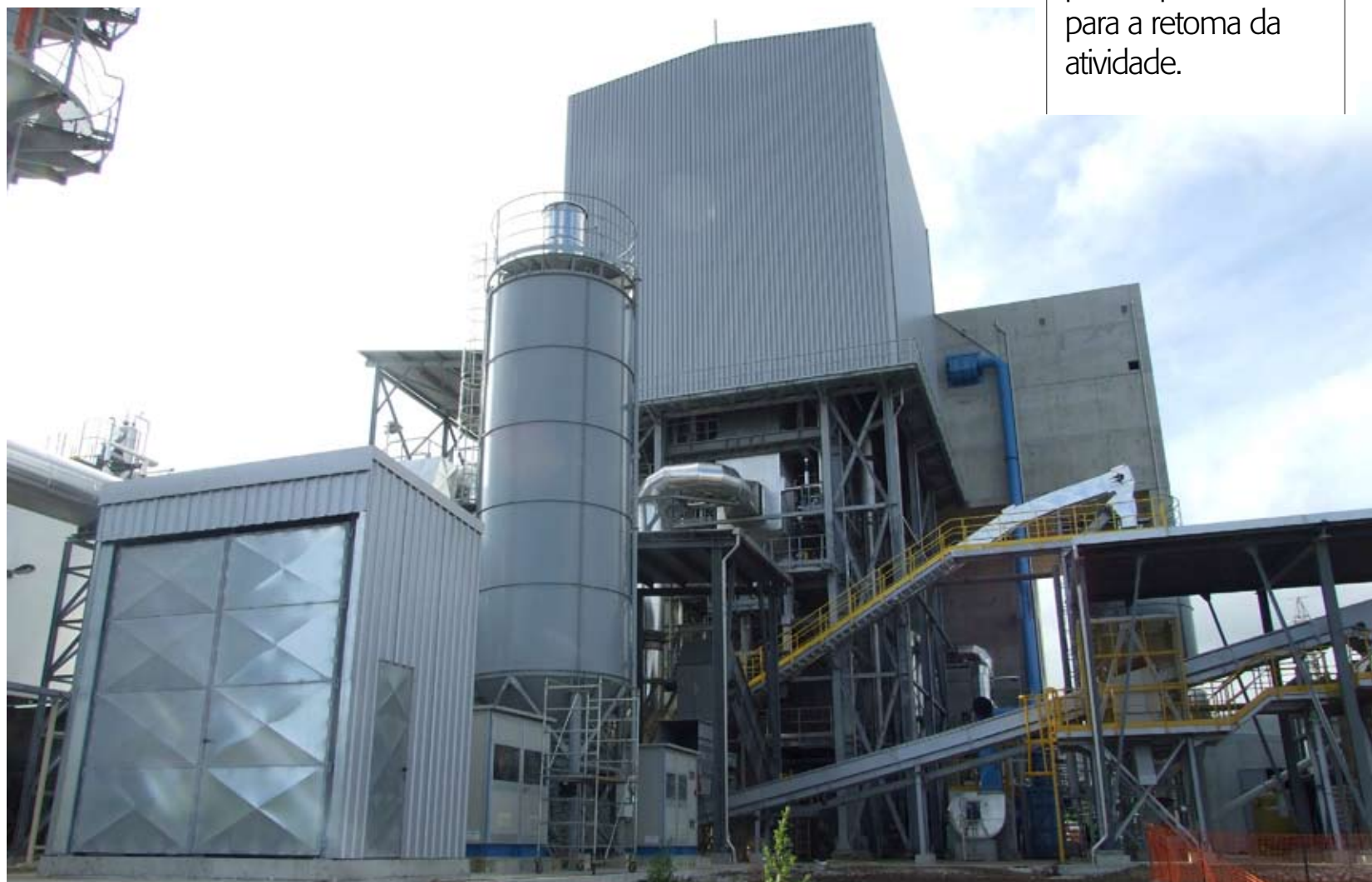
INCINERADORA. Central de valorização energética da Terceira trata resíduos de várias ilhas do arquipélago
