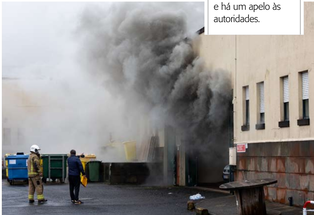
HOSPITAL. Incêndio de 4 de maio do ano passado começou numa bateria de condensadores de correção do fator de potência
